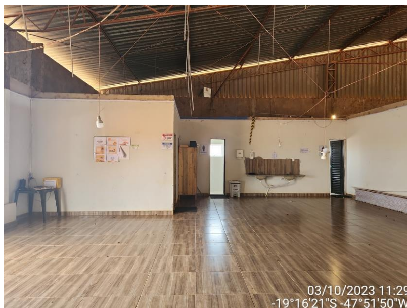
Figura 17 Entrada do escritório
