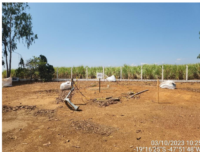
Figura 27 Fossa séptica casa 2
