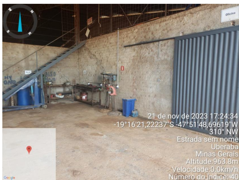
Figura 21 Entrada da oficina
