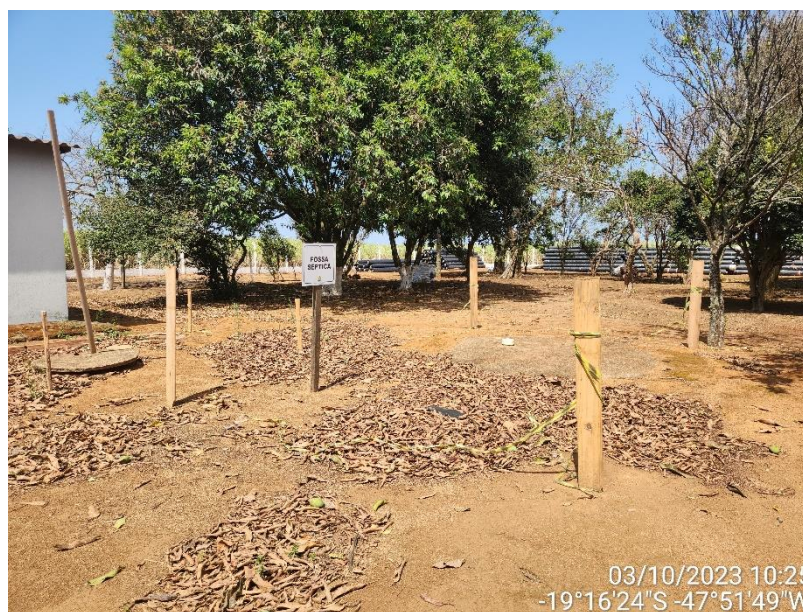
Figura 29 Fossa séptica da casa 4
