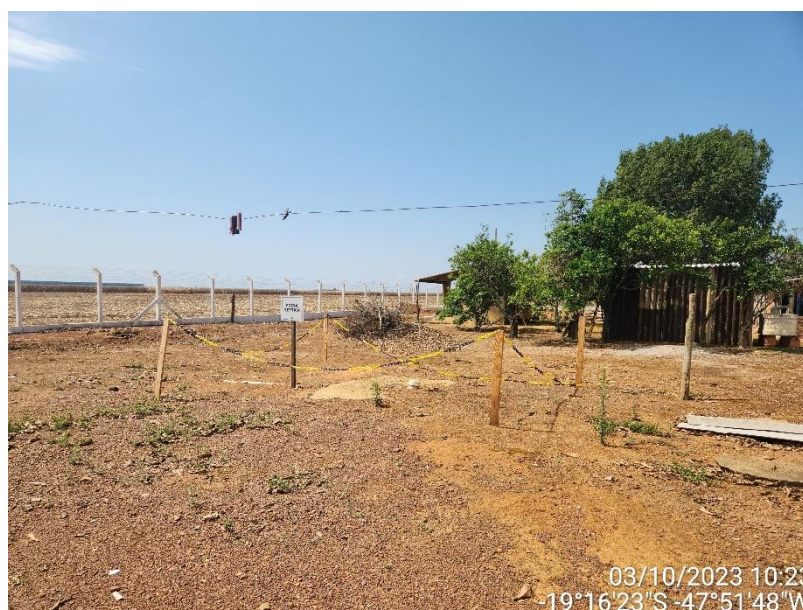
Figura 26 Fossa séptica casa 1
