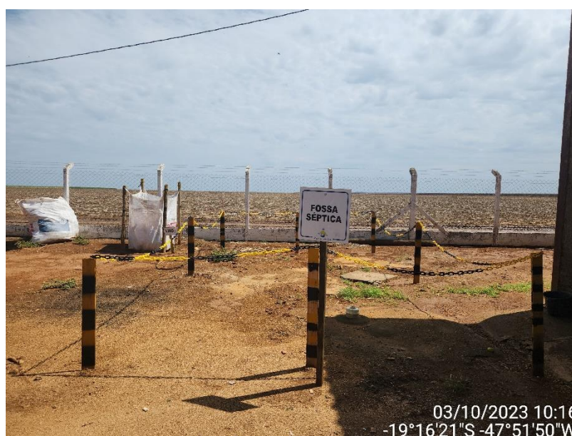
Figura 30 Fossa séptica do escritório/refeitório
