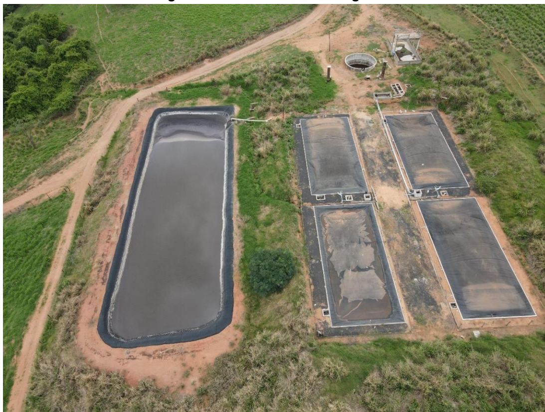
Figura 7.18 Estruturas do biodigestor
