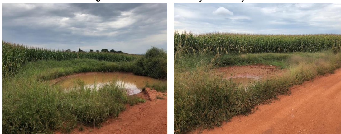
Figura 6.15 Bacia de contenção/infiltração
