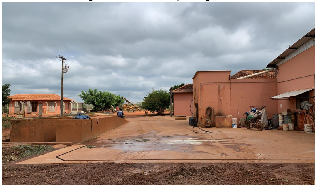
Figura 7.8 Lavador de máquinas agrícolas
