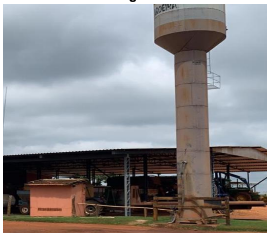
Figura 7.10 Poço Tubular com caixa d'água
