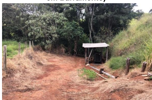
Figura 7.22 Casa da Bomba (Captação em Barramento)
