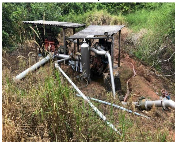
Figura 7.11 Casa de Bomba (Captação Direta)
