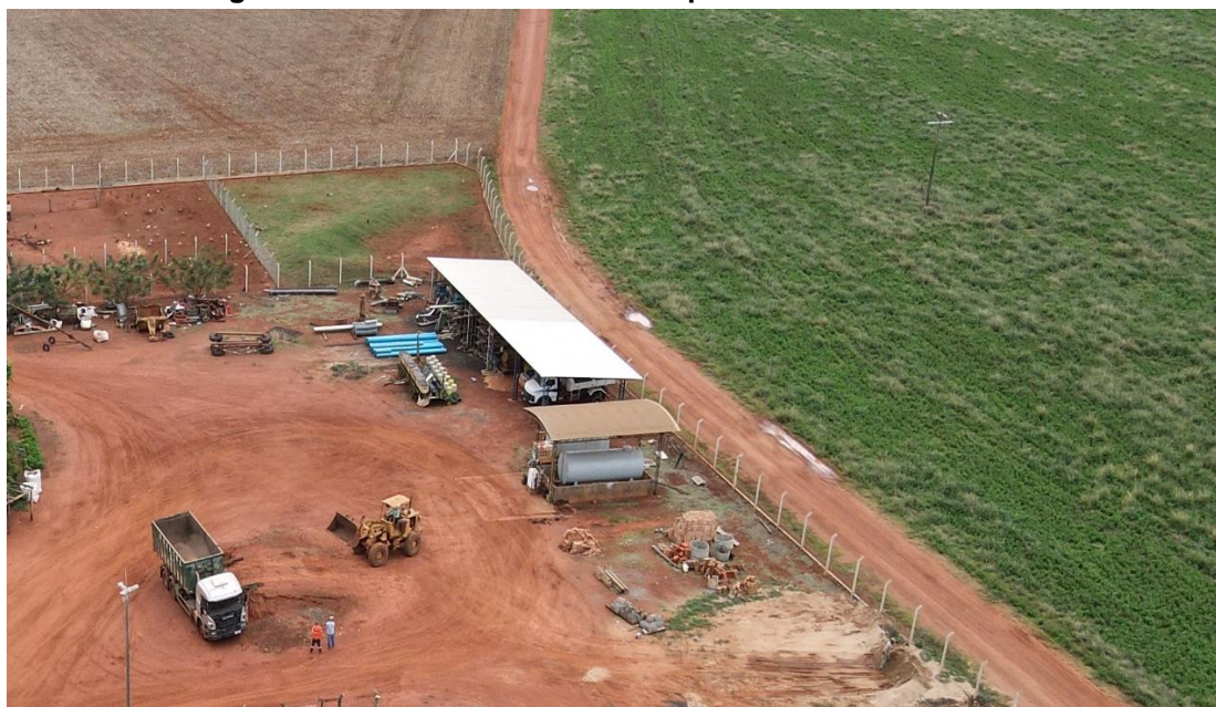
Figura 7.9 Posto de combustível e pista de abastecimento
