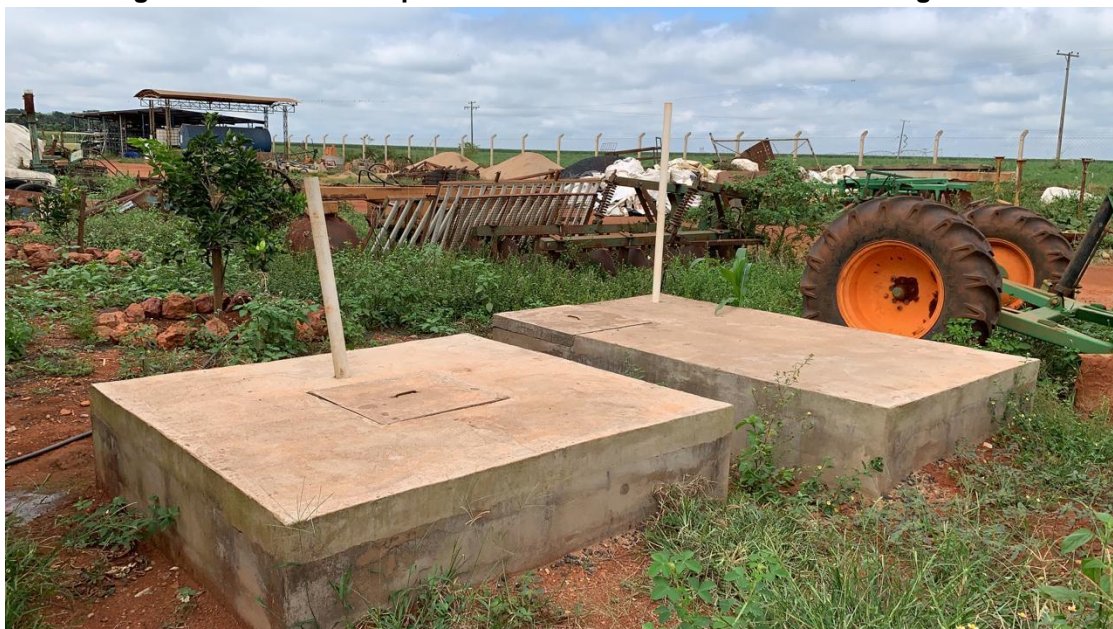
Figura 15.15 Fossas sépticas - Banheiro barracão de insumos agrícolas
