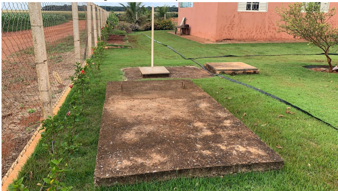
Figura 19.6 Fossa séptica e Sumidouro
