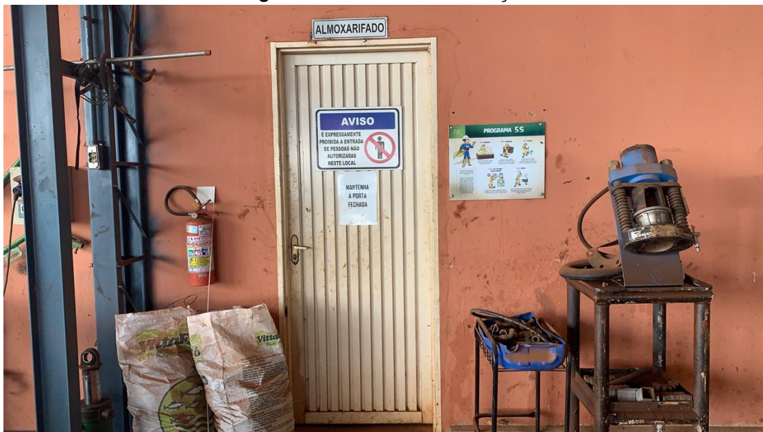
Figura 16.3 Placas de sinalização
