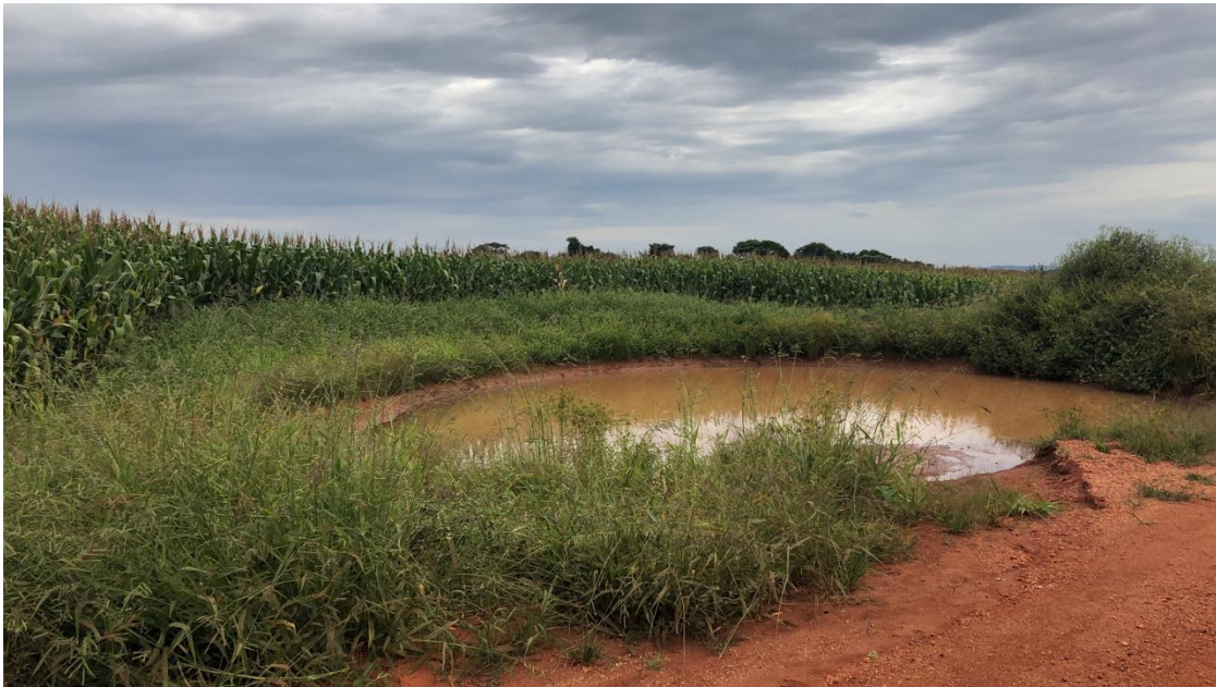
Figura 19.1 Bacia de contenção
