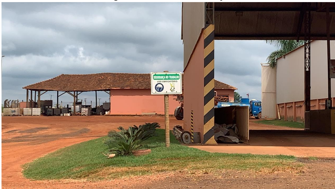
Figura 16.14 Placa de sinalização
