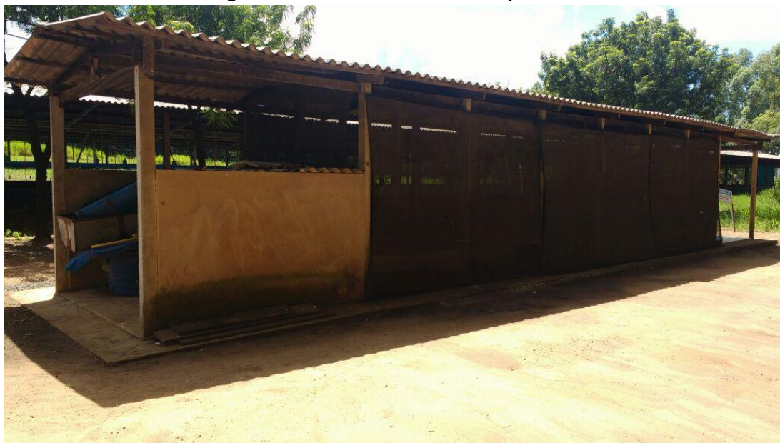
Figura 15.37 Vista lateral da Composteira
