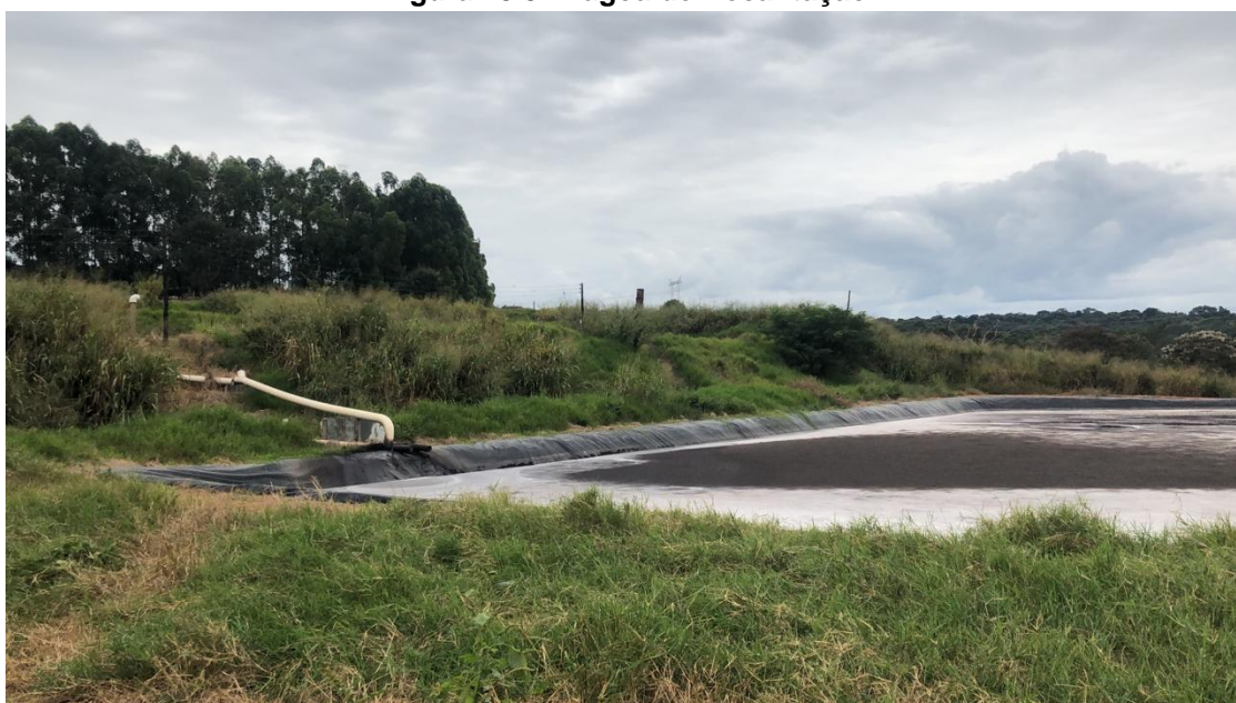
Figura 15.34 Lagoa de Decantação
