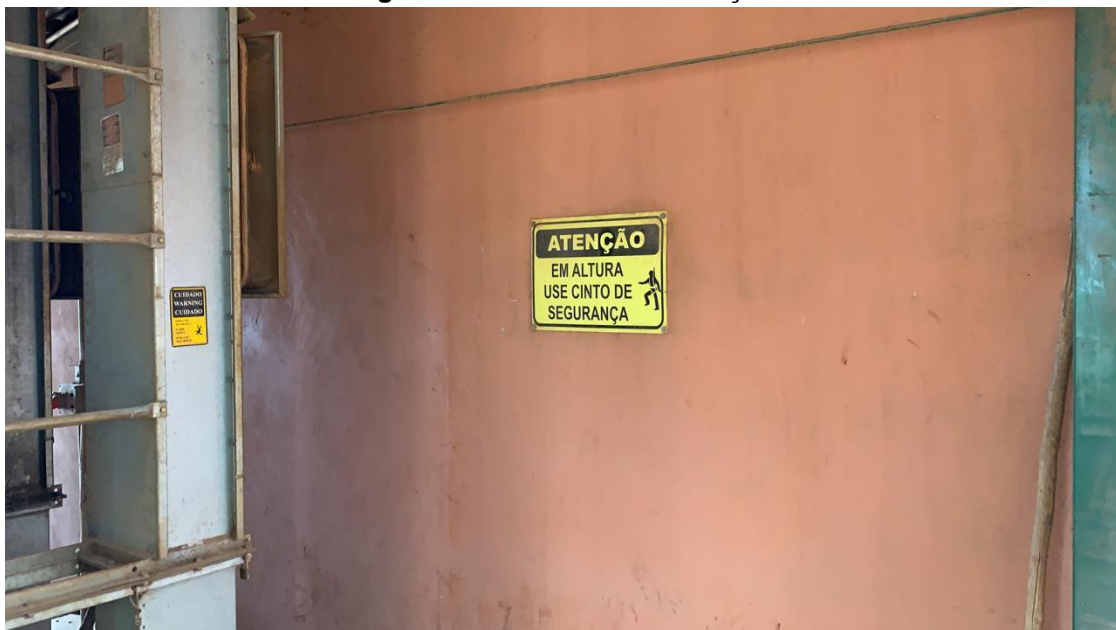
Figura 16.11 Placa de sinalização
