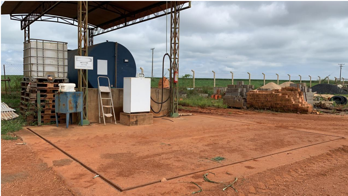
Figura 15.7 Canaleta de contenção / Pista de abastecimento
