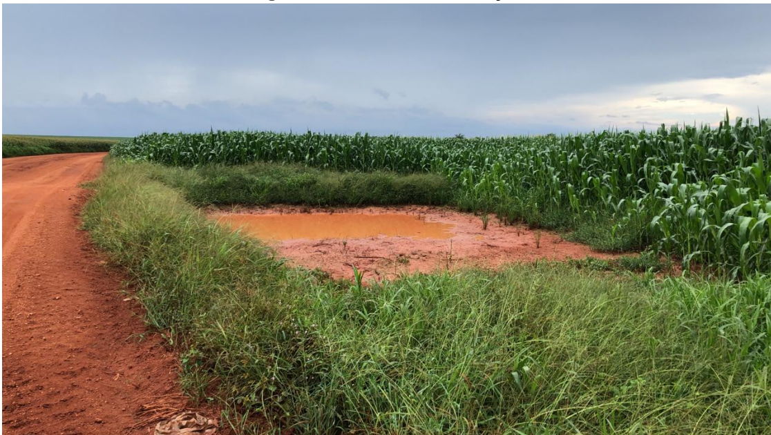
Figura 19.2 Bacia de contenção
