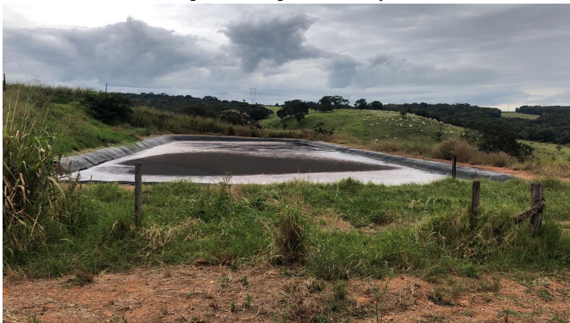
Figura 15.35 Lagoa de Decantação
