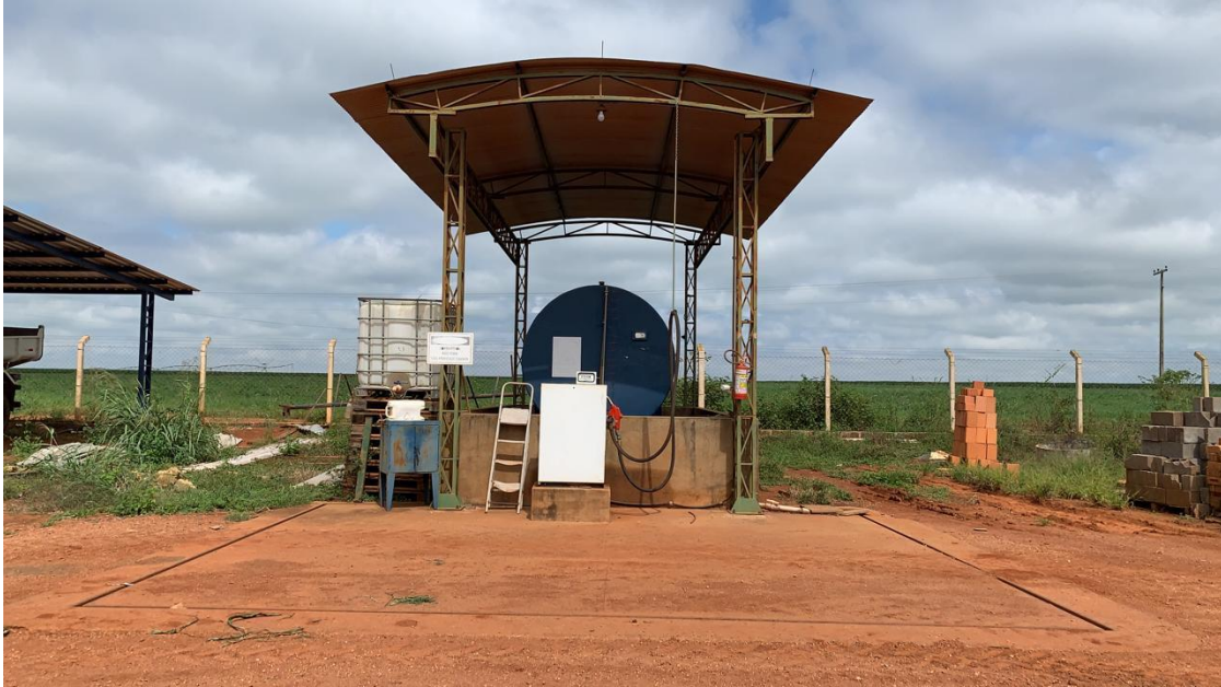
Figura 15.6 Pista de abastecimento
