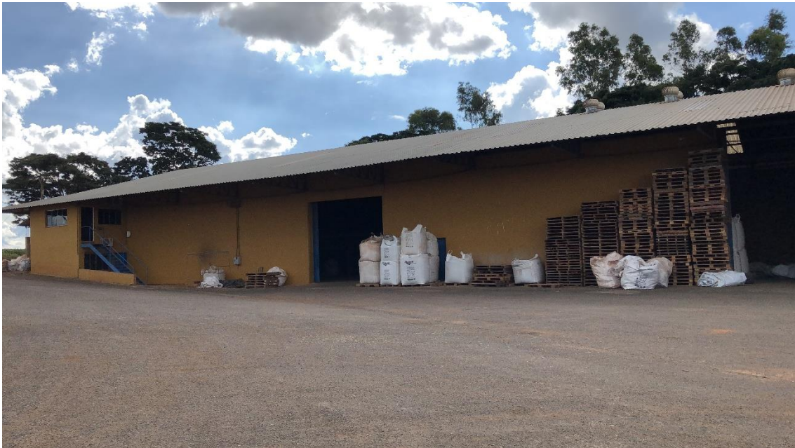
Figura 8.10 – Galpão de beneficiamento e armazenamento dos grãos produzidos no empreendimento e sementes que serão utilizadas no plantio
