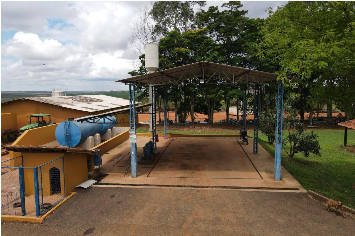
Figura 6.4 – Posto de combustível da propriedade – Sede do escritório
