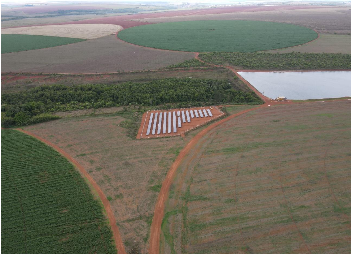
Figura 6.6 – Usina Solar Fotovoltaica – UFV vista por drone
