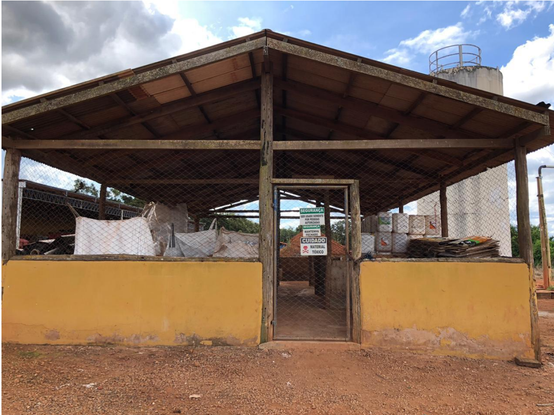
Figura 8.9 – Galpão de armazenamento de embalagens vazias de agrotóxicos
