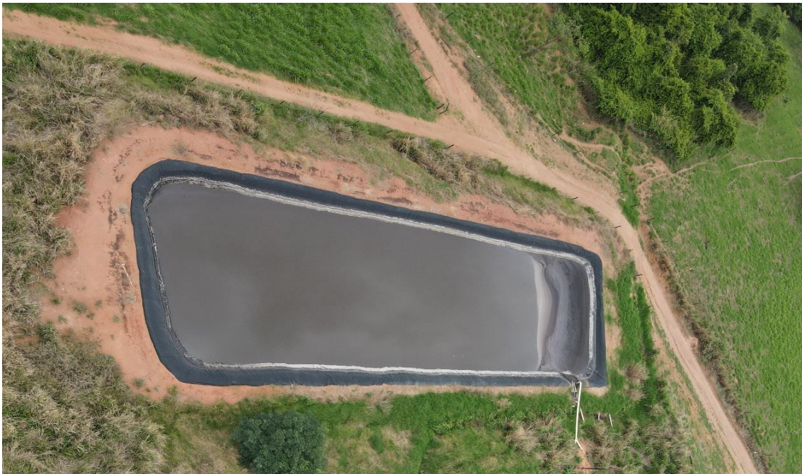
Figura 2.25 Lagoa de Decantação (tanque impermeável)
