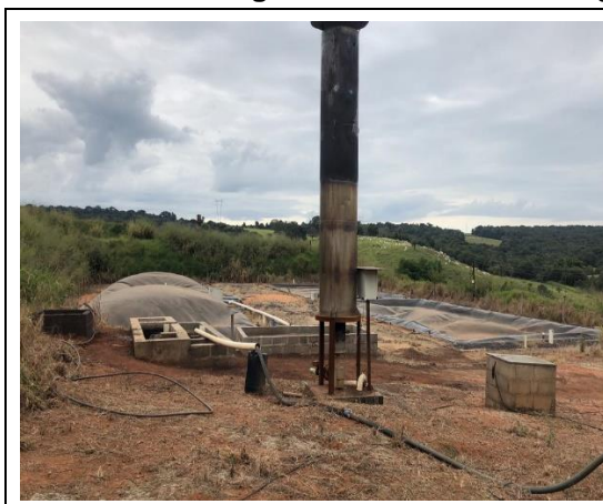
Figura 2.18 Queimador de gás e estrutura do biodigestor
