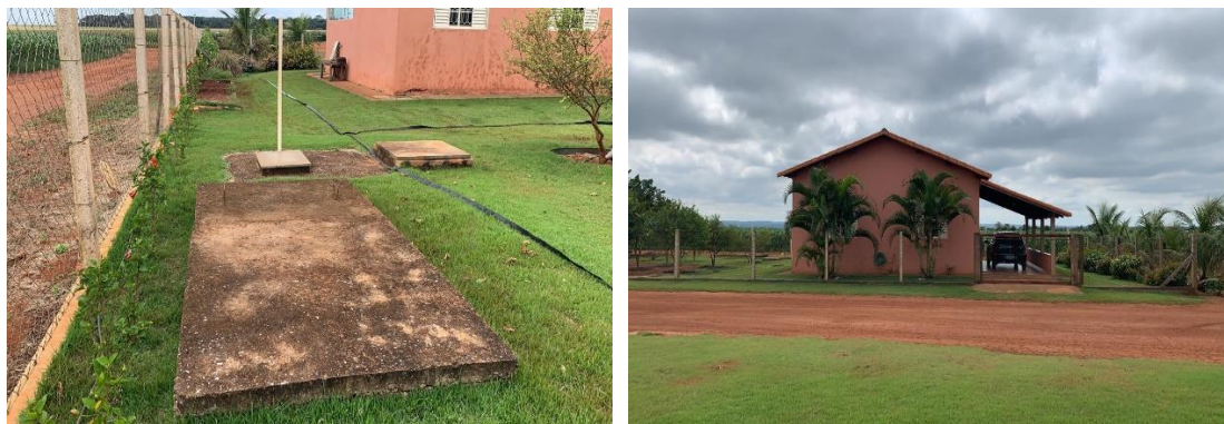
Figura 2.6 Fossa séptica – Casa dos funcionários (Escritório)
