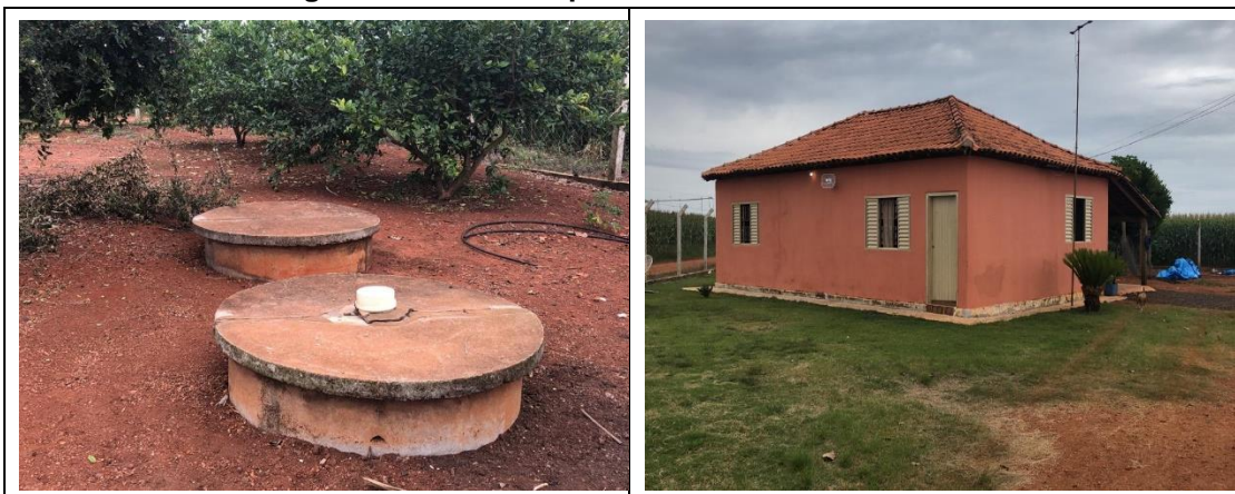
Figura 2.10 Fossa séptica – Casa de funcionários
