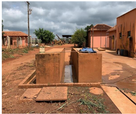
Figura 2.22 Rampa do lavador dos maquinários agrícolas e CSAO
