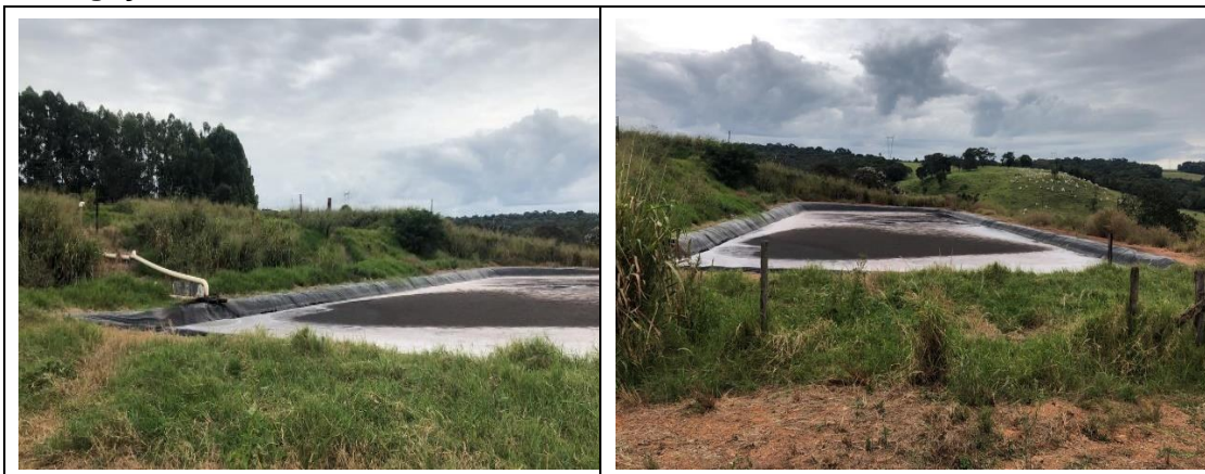
Figura 2.19 Lagoa de decantação – dejetos da suinocultura que vão ser utilizados na fertirrigação da lavoura
