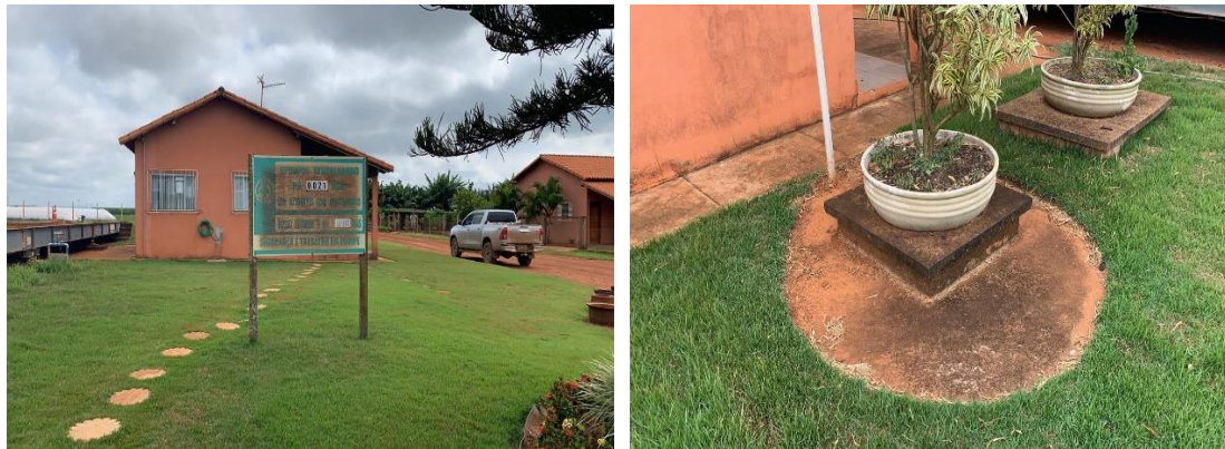
Figura 2.5 Fossa séptica – Escritório
