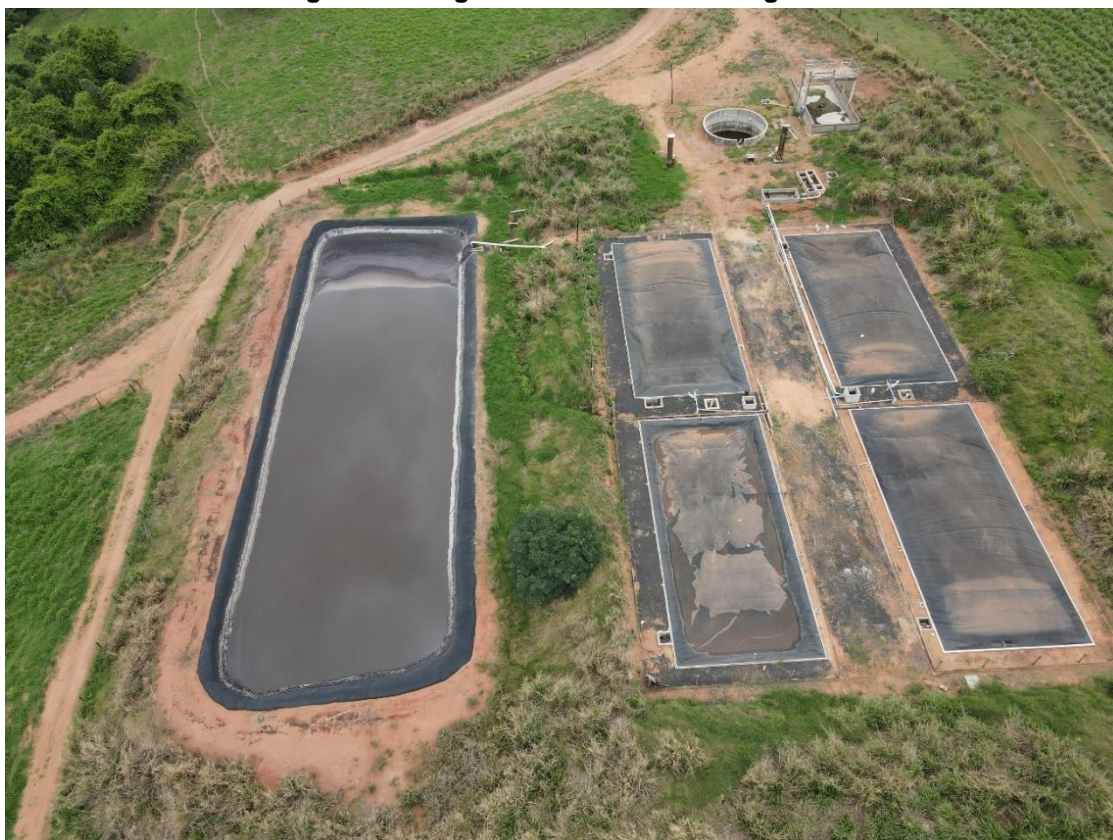
Figura 2.14 Figura Estruturas do biodigestor
