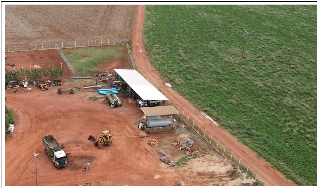
Figura 2.24 Posto de combustível, pista de abastecimento e CSAO
