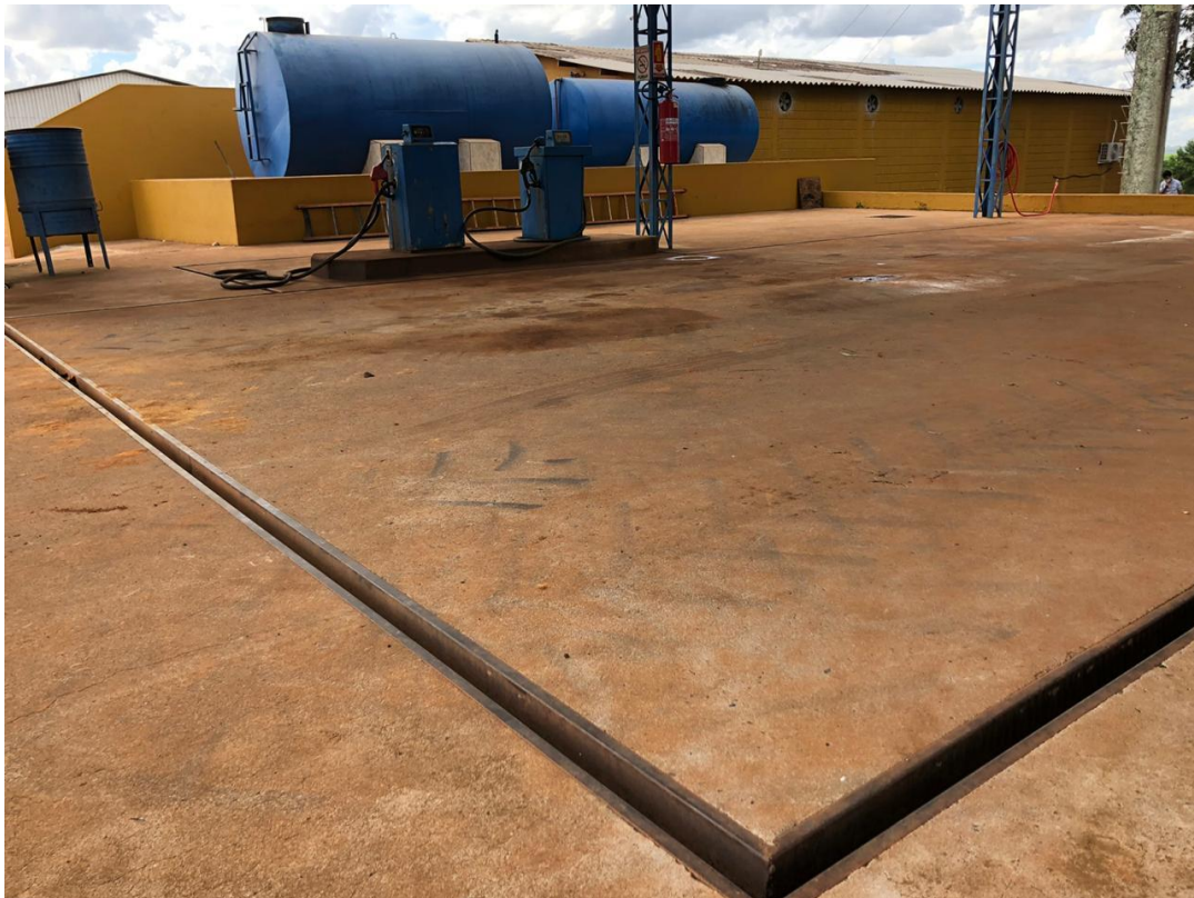
Figura 3.6 – Canaleta de contenção / Pista de abastecimento
