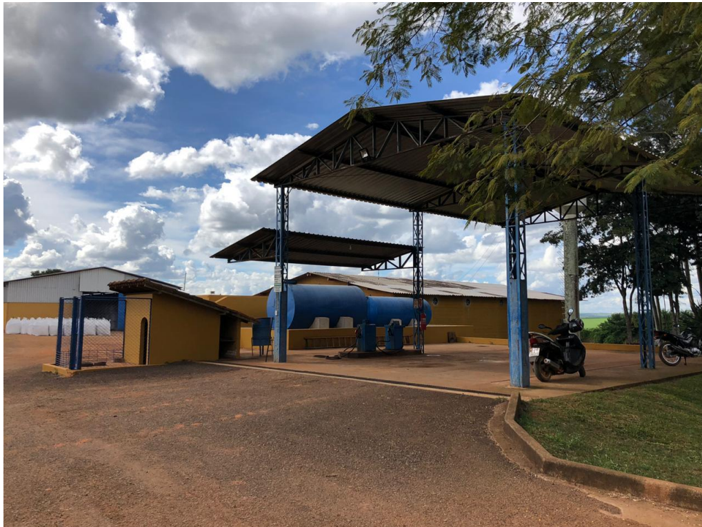
Figura 3.4 – Pista de abastecimento
