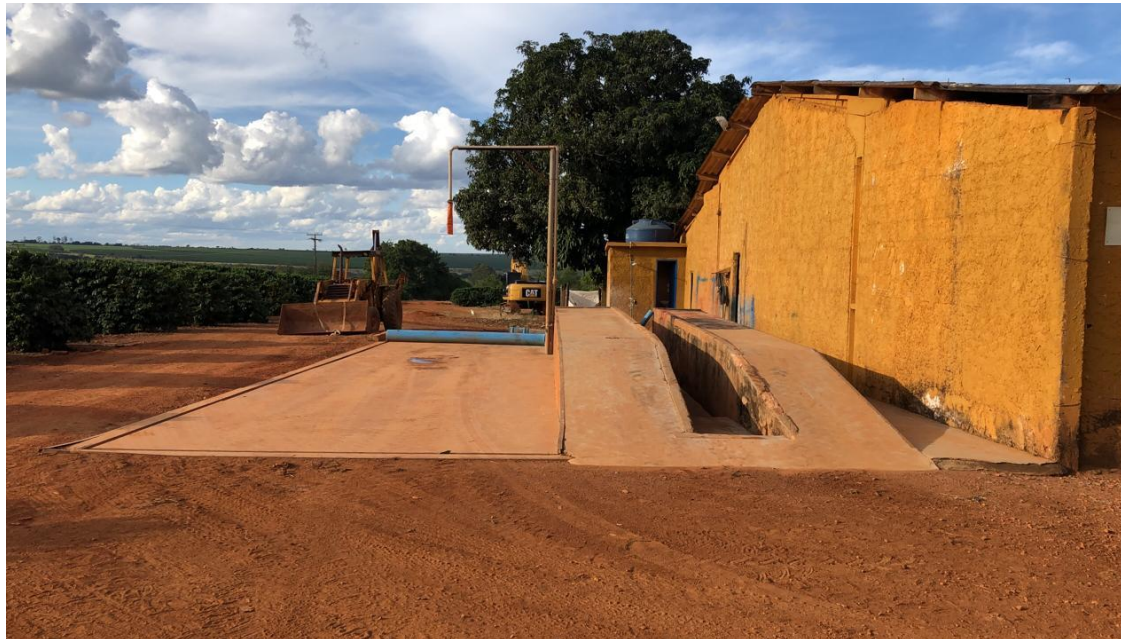
Figura 3.11 – Lavador de máquinas
