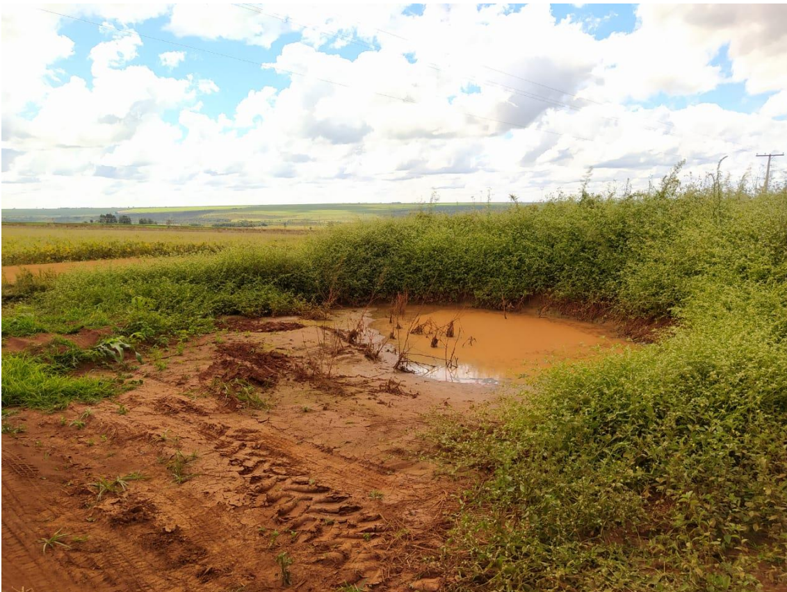
Figura 7.2 – Bacia de contenção
