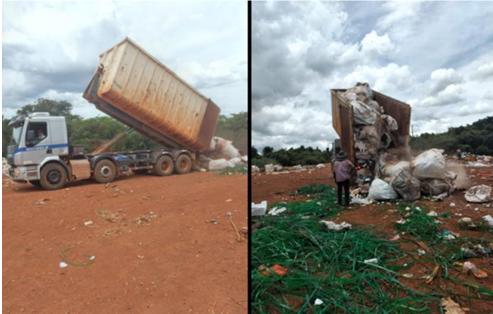
Figura 3.22 – Descarregamento do lixo no Aterro Sanitário de Romaria
