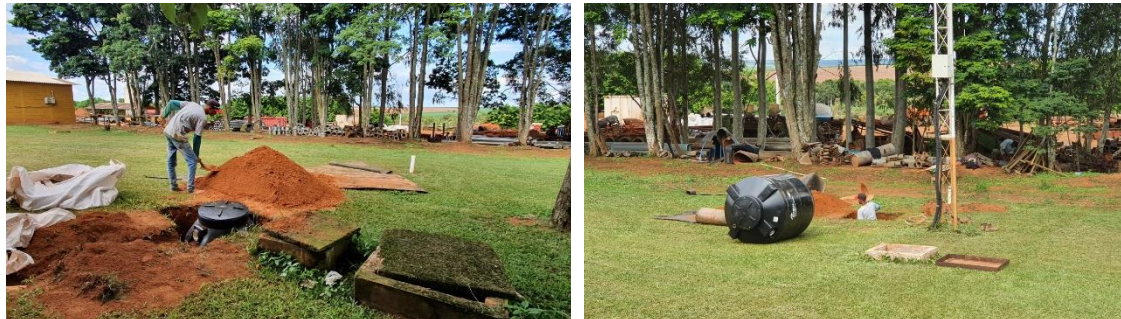
Figura 3.16 – Instalação dos Biodigestores no empreendimento
