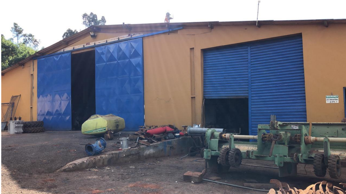
Figura 3.14 – Oficina de maquinários - Processo de adequação (Construção de canaletas contenção)
