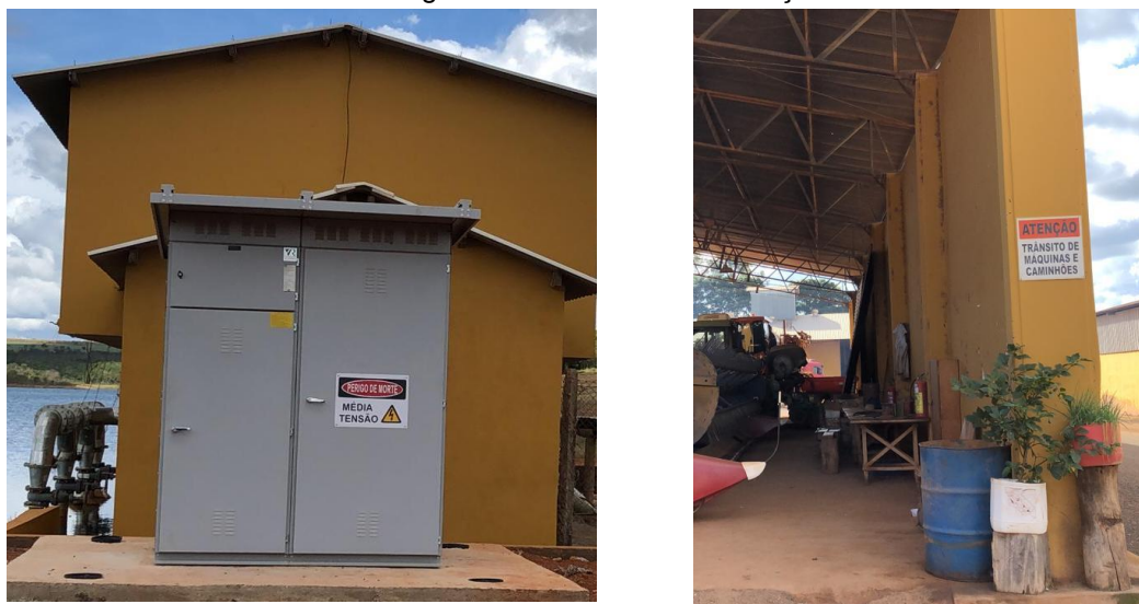
Figura 4.6 – Placa de sinalização
