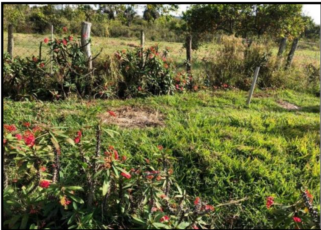
Figura 4.23. Fossa séptica 04 - Sede Fazenda São Jorge
