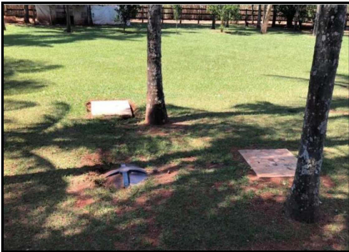
Figura 4.24. Fossa séptica 05 - Sede Fazenda Santa Fé
