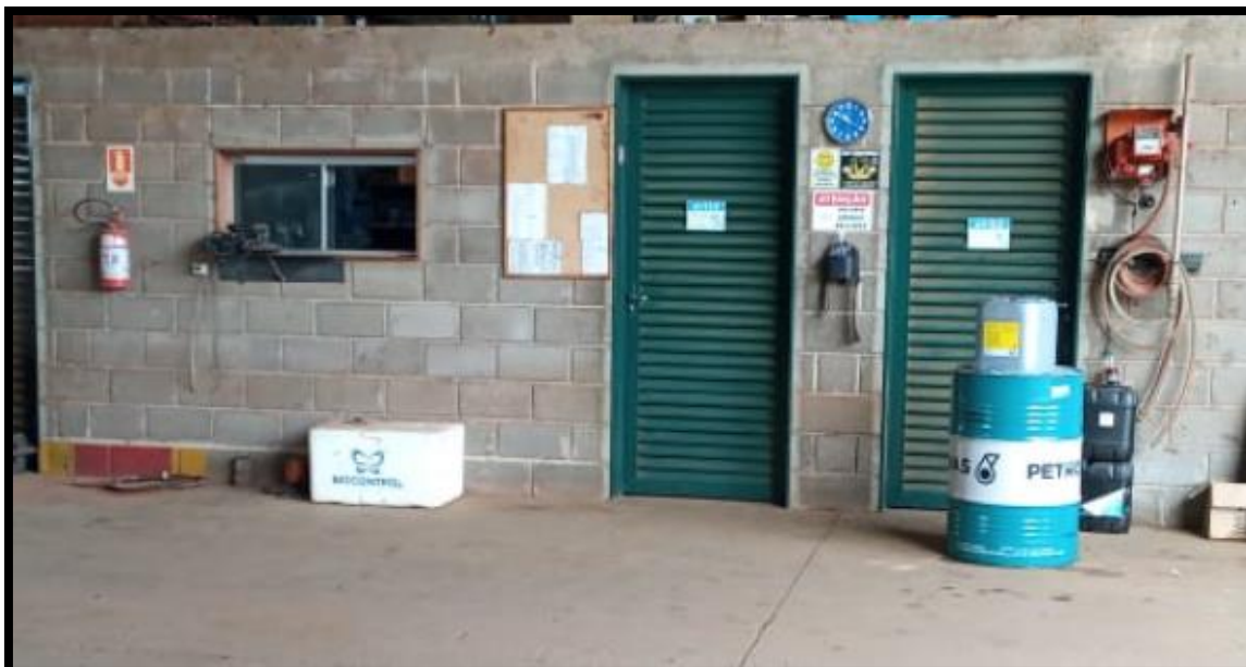
Figura 5.7. Extintor e placas de sinalização - Oficina de maquinários e almoxarifado
