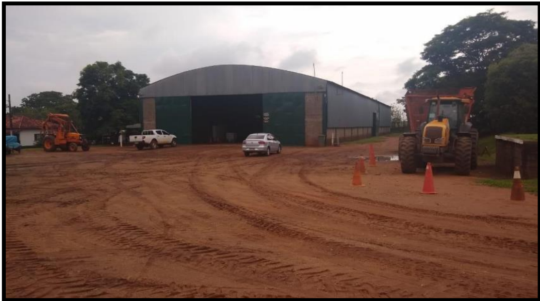
Figura 4.11. Galpão de maquinários agrícolas e oficina
