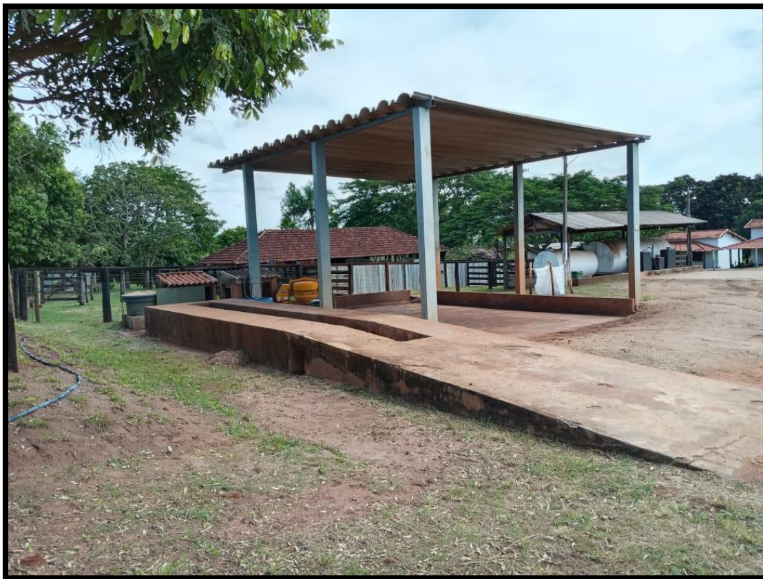
Figura 4.7. Lavador de máquinas e pátio coberto
