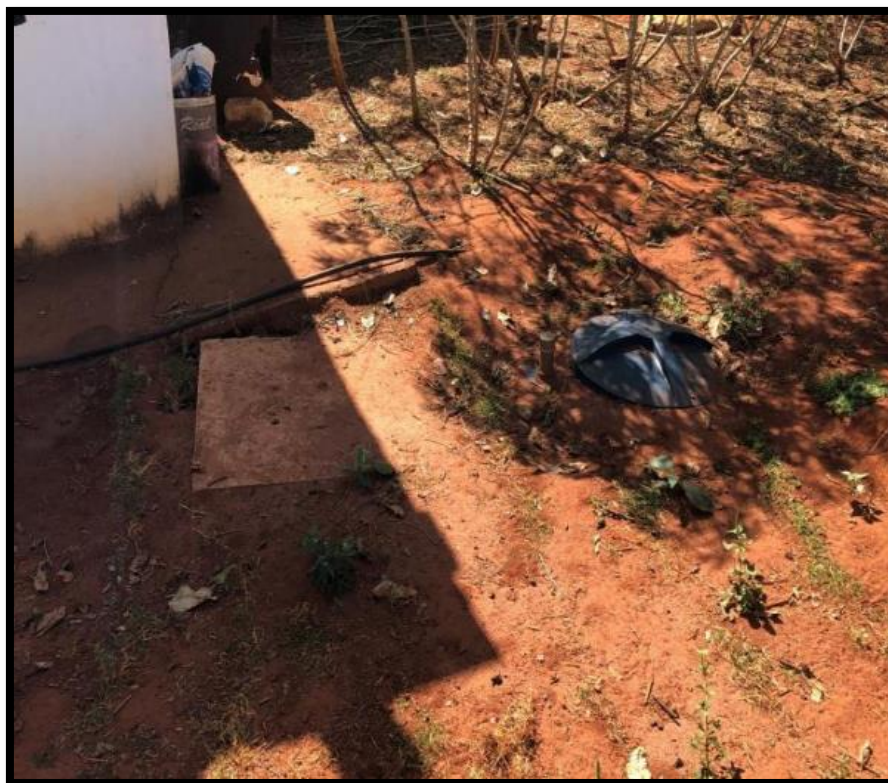
Figura 4.25. Fossa séptica 06 - Casa do funcionário da Fazenda Santa Fé
