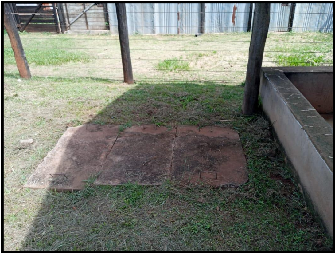
Figura 4.9. Caixa separadora de água e óleo - Lavador de maquinários
