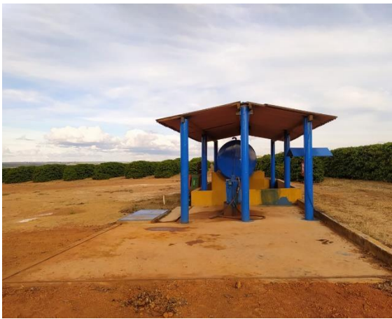
Figura 8.17 – Poço tubular com casa da bomba
