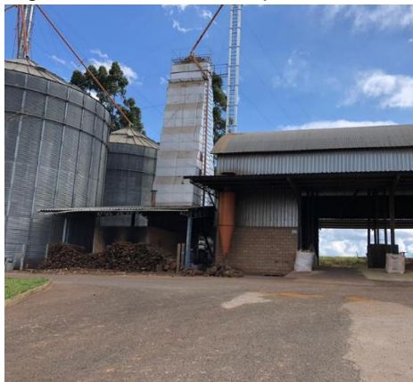
Figura 6.3 – a Estrutura para beneficiamento primário – Moega, Secador e Silos
