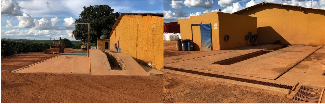
Figura 8.14 – Lavador de máquinas agrícolas (sede do escritório e sede do café)
