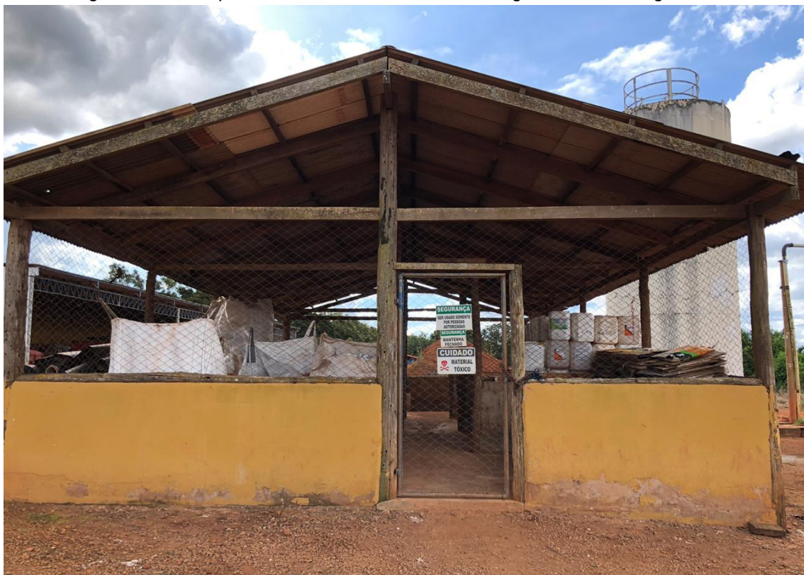
Figura 8.11 – Galpão de armazenamento de embalagens vazias de agrotóxicos
