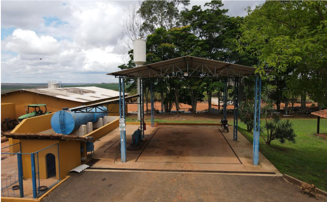
Figura 6.4 – Posto de combustível da propriedade – Sede do escritório
