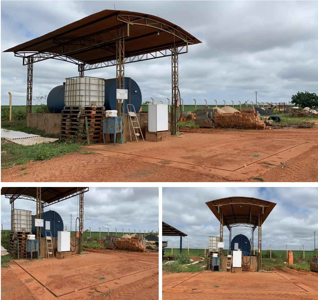
Figura 6.17 Posto de abastecimento de combustíveis com canaletas
