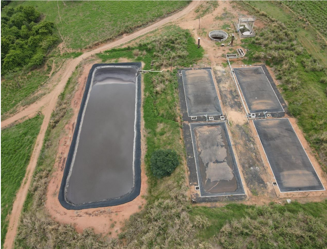
Figura 6.6 Estruturas do biodigestor
