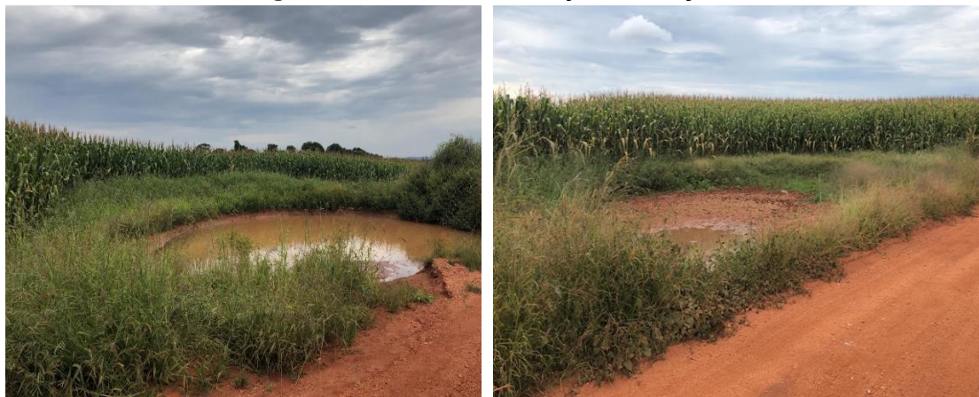
Figura 6.15 Bacia de contenção/infiltração
