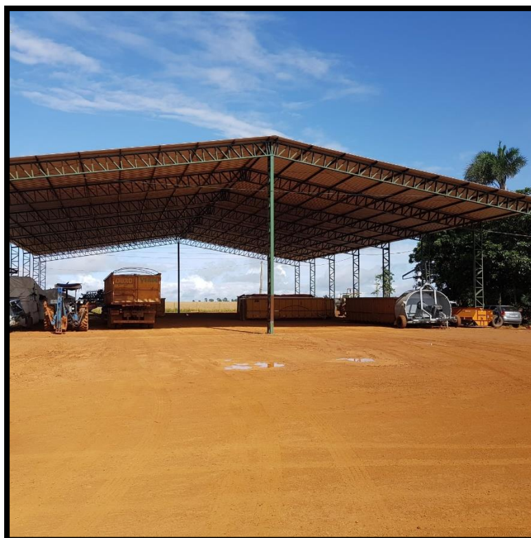
Foto 09: Barracão de maquinários
