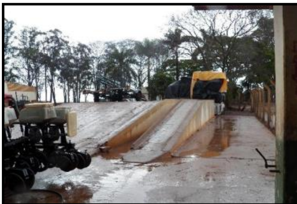
Foto 07: Lavador de máquinas e veículos
