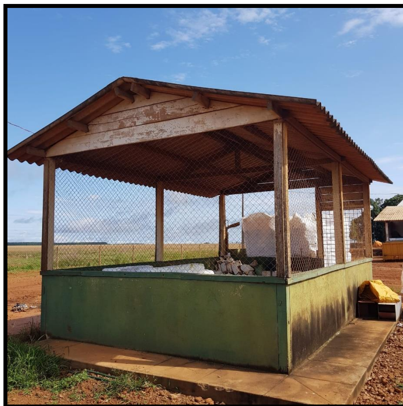
Foto 08: Galpão de armazenamento de embalagens vazias de agrotóxicos
