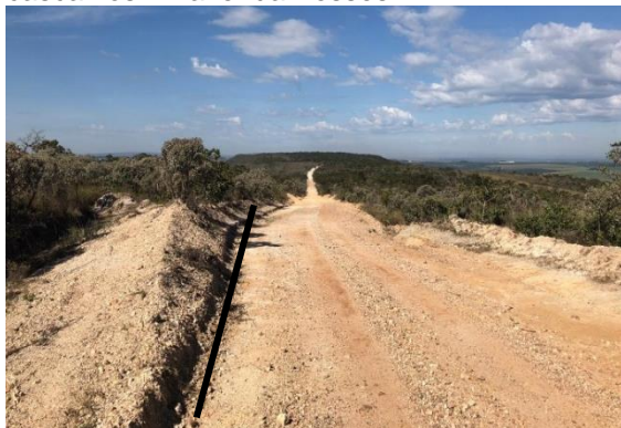
Foto 16: Corte transversal da estrada na propriedade feito a manutenção em cascalhos – Fazenda Posses.
