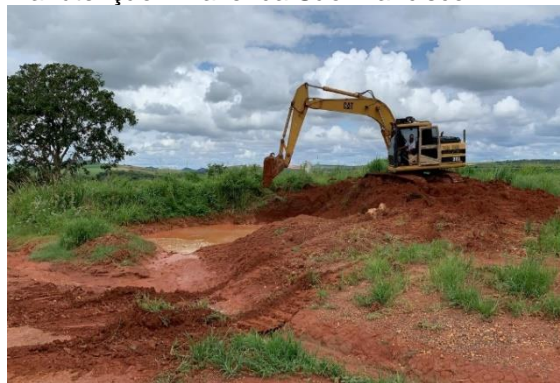
Foto 4: Bacia de contenção em manutenção – Fazenda São Francisco.
