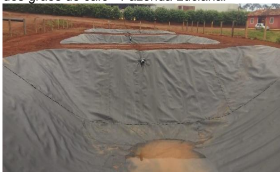
Foto 46: Tanque de decantação de efluentes provenientes do beneficiamento dos grãos de café - Fazenda Luciana.
