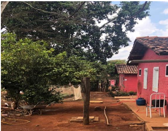
Foto 18: Caixas de captação dos efluentes sanitários com destino a fossa séptica da casa dos funcionários – Fazenda Luciana.
