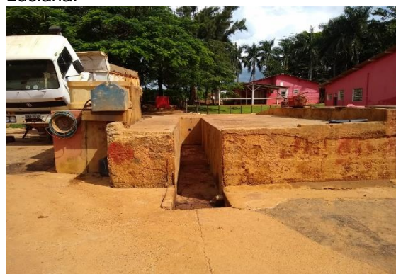
Foto 33: Lavador de máquinas com a área impermeabilizada e a saída para a caixa separadora de água e óleo – Fazenda Luciana.
