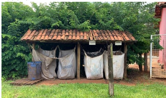
Foto 56: Ponto de coleta de resíduos sólidos (Ecoponto) – Cantina da Fazenda Luciana.
