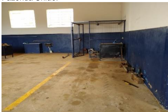
Foto 89: Área interna da oficina da Fazenda União.
