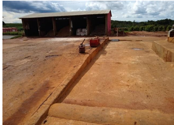
Foto 35: Lavador de máquinas com a área impermeabilizada – Fazenda Luciana.
