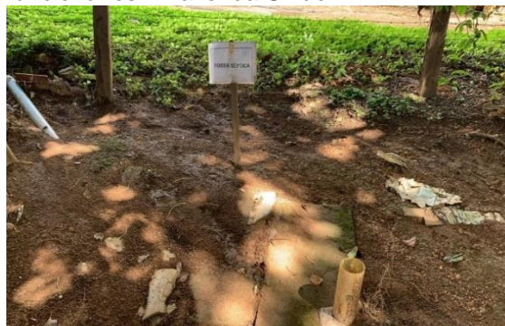
Foto 25: Fossa séptica da casa de funcionários – Fazenda União.
