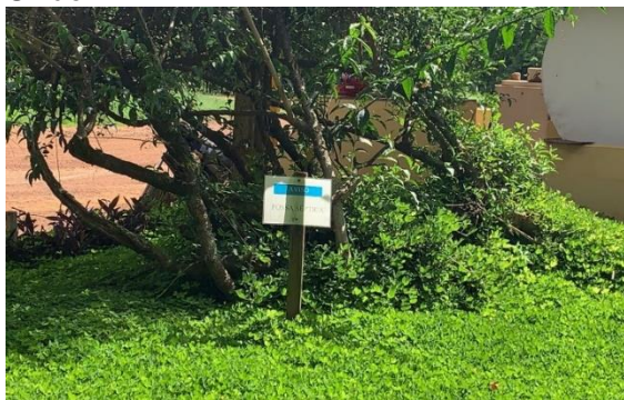
Foto 24: Fossa séptica da sede – Fazenda União.
