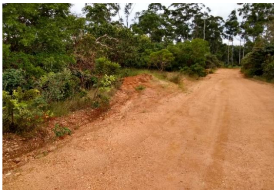
Foto 14: Ruas de café, feito a manutenção com lâmina niveladora, cascalhos e bigode – Fazenda Luciana.
