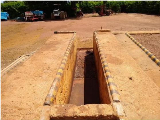
Foto 42: Lavador de máquinas com a área impermeabilizada e a saída para a caixa separadora de água e óleo – Fazenda União.
