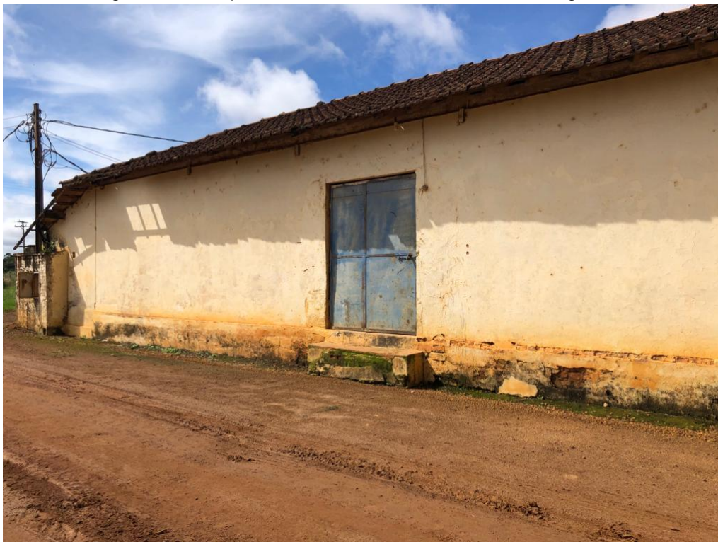
Figura 7.11. Galpão de armazenamento de defensivos agrícolas
