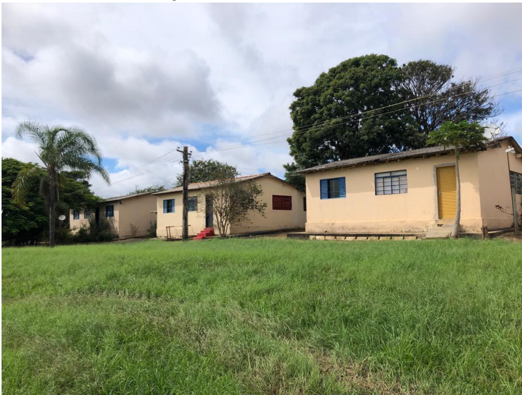
Figura 7.2. Casas dos funcionários
