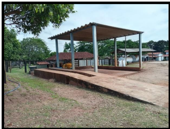
Figura 6.3. Bacia de contenção / Serragem para absorção do óleo - Oficina mecânica
