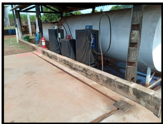
Figura 6.1. Canaleta de contenção / Caixa separadora de água e óleo - pista de abastecimento
