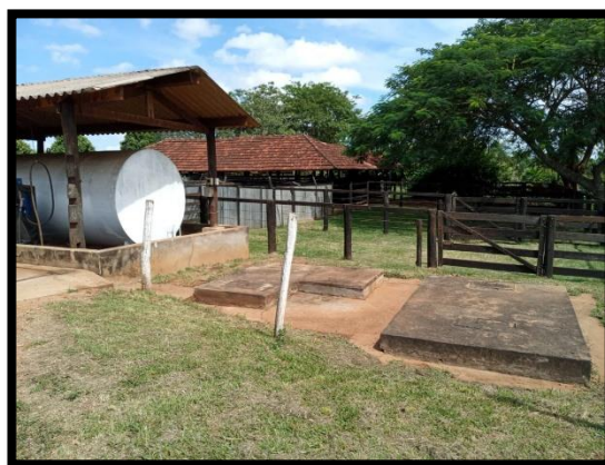
Figura 6.1. Canaleta de contenção / Caixa separadora de água e óleo - pista de abastecimento
