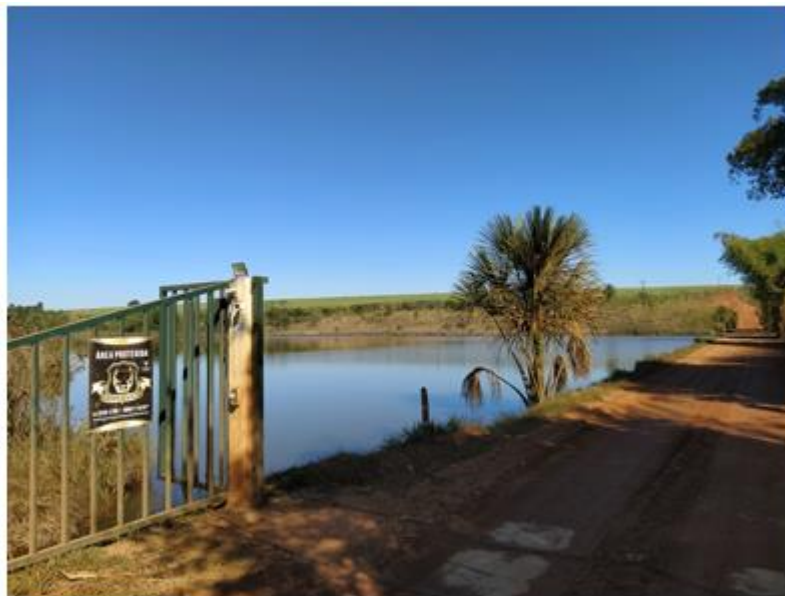
Figura 10.33. Grande represamento, com vereda ao fundo
