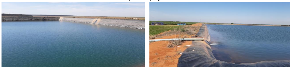
Figura 10.27 – Piscinões abastecidos com água explotada em 25 poços tubulares destinada à irrigação de culturas. (A) – Piscinão 01 abastecido por 11 poços tubulares e (B) – Piscinão 02 abastecido por 15 poços tubulares
