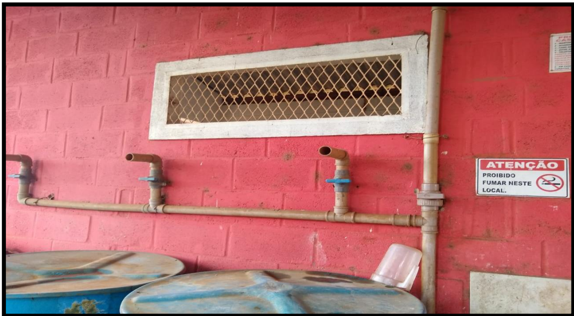
Local de abastecimento dos pulverizadores
