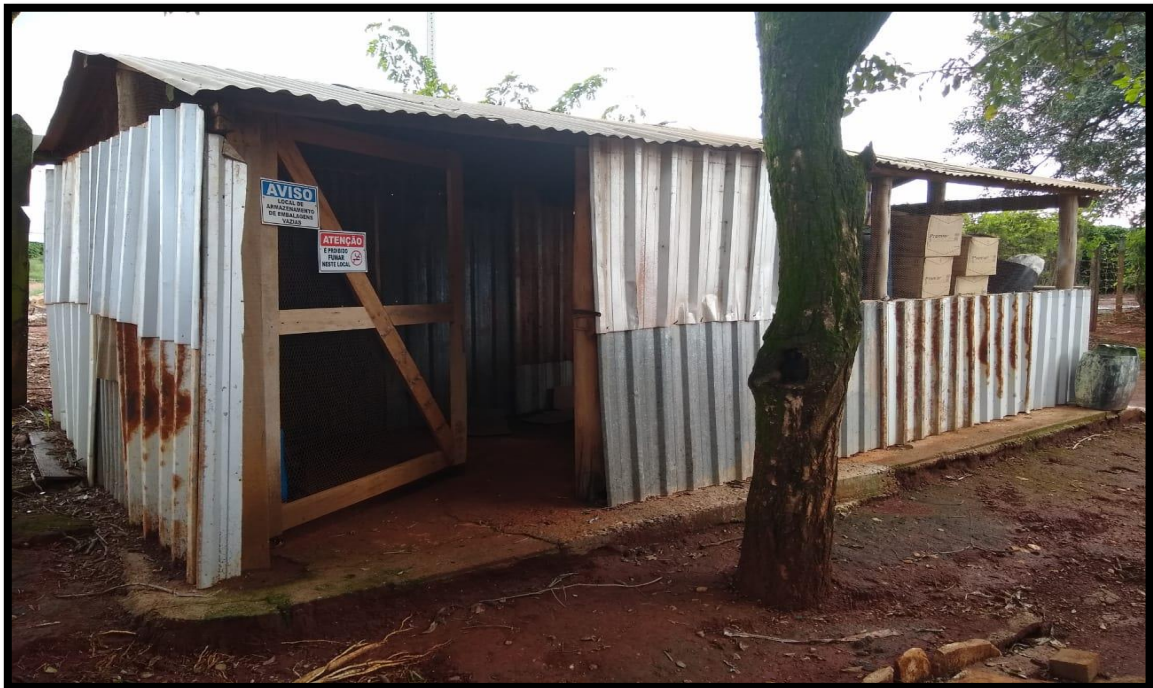
Deposito de Embalagens Vazias de agrotóxico
