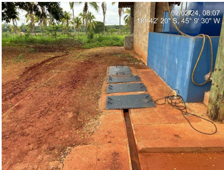
Figura 7.5.-1: CSAO conexas ao ponto de abastecimento de maquinários agrícolas.
