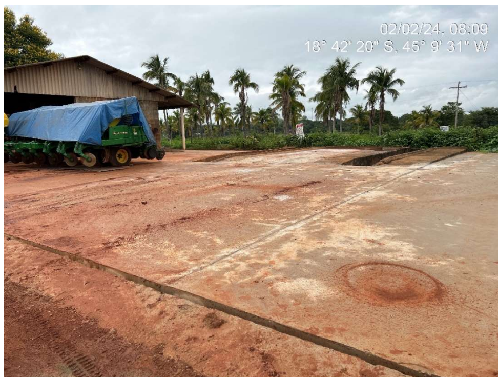
Figura 7. 5-4: Lavador de maquinários com canaletas ligadas à CSAO junto ao ponto de abastecimento.
