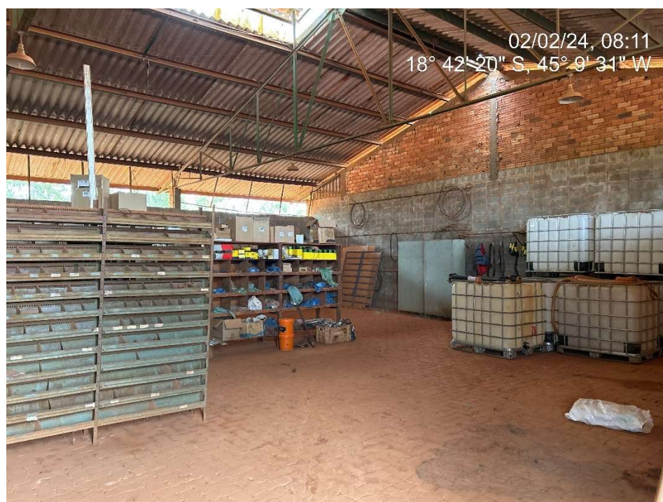
Figura 5.1-6: Galpão de guarda de ferramentas e utensílios.
