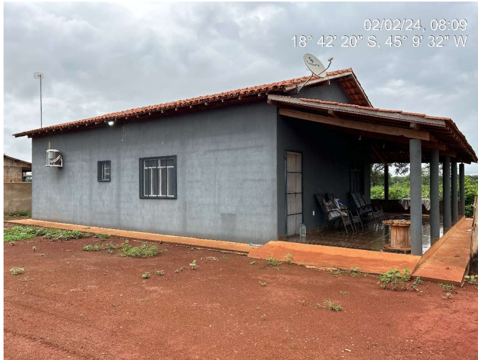
Figura 5.1-3: Casa de funcionários.
