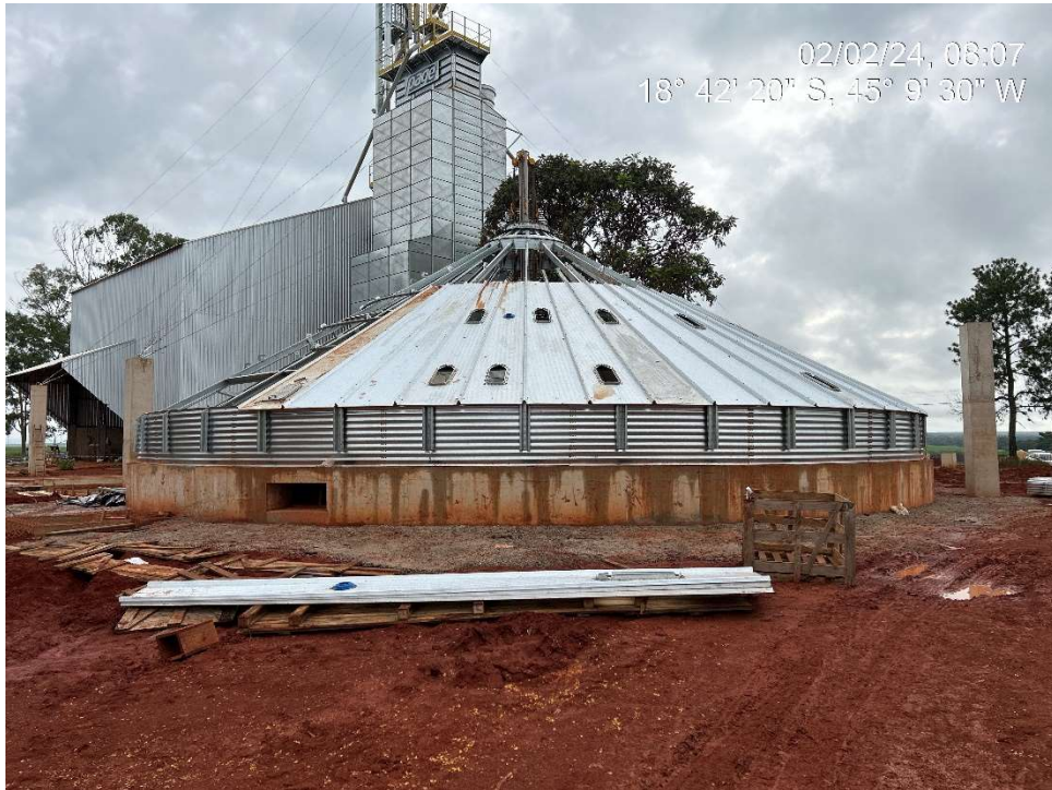
Figura 5.1-1: Silo de armazenagem de grãos em construção.
