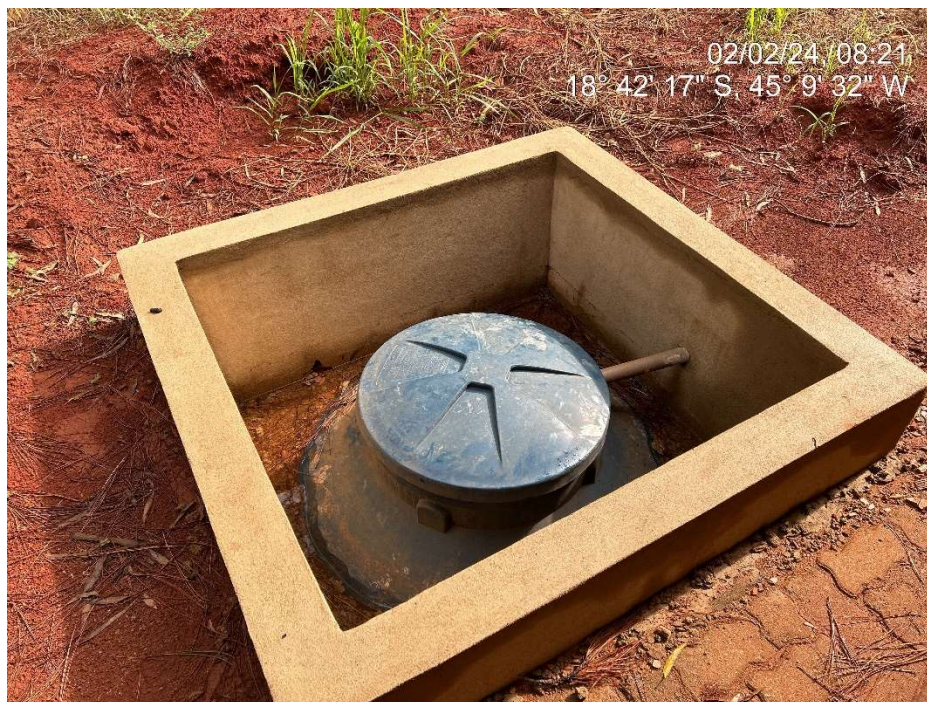
Figura 7. 5-14: Biodigestor conexo à estruturas do galpão de defensivos agrícolas, maquinários e de embalagens vazias.
