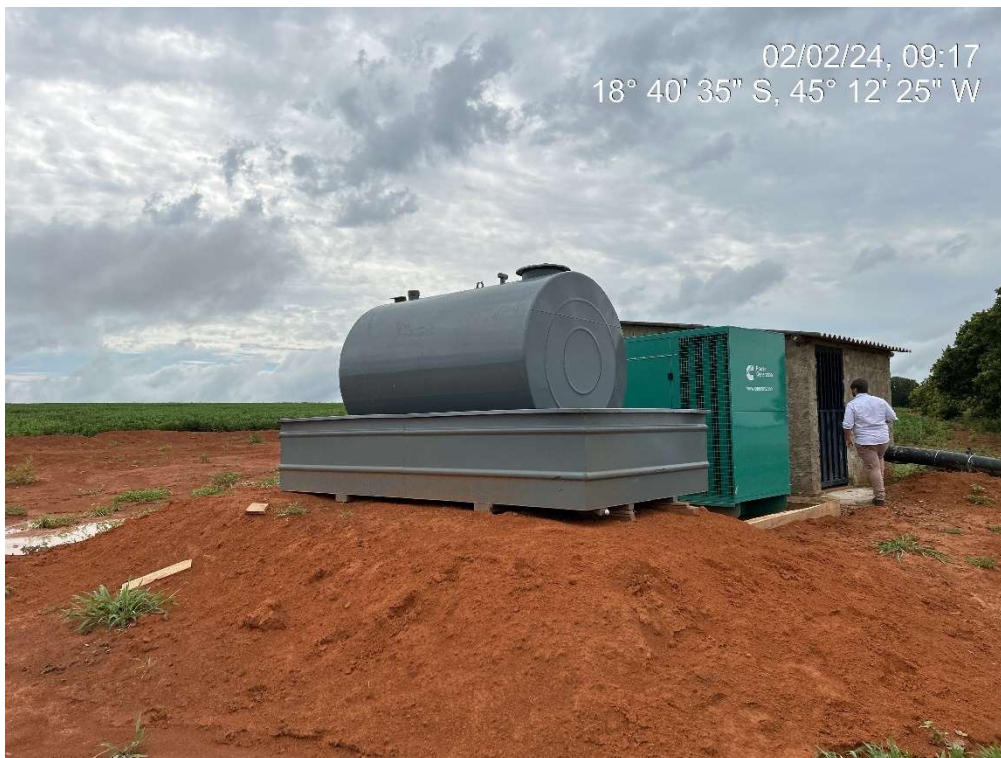
Figura 5.20: Bomba de captação de água.
