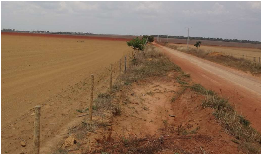
Figuras 13.7.6-3: Principal via de acesso que corta a ADA do empreendimento. Observar bolsões para a retenção de águas pluviais.
