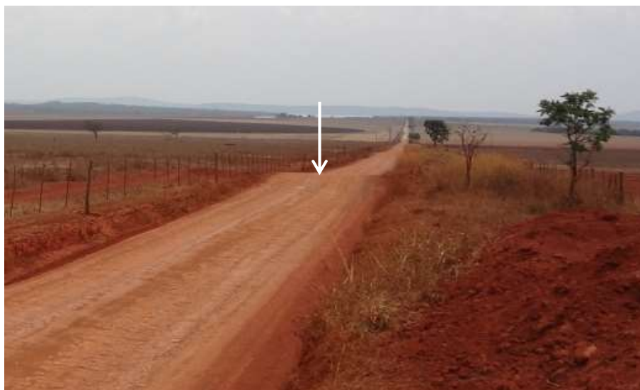
Figuras 13.7.6-4: Principal via de acesso que corta a ADA do empreendimento. Observar camalhões em nível associado a bolsões para a retenção de águas pluviais.
