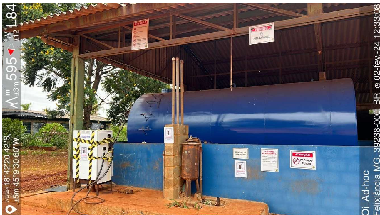
Figura 8.1: Posto de abastecimento interno interditado com placas indicativas.
