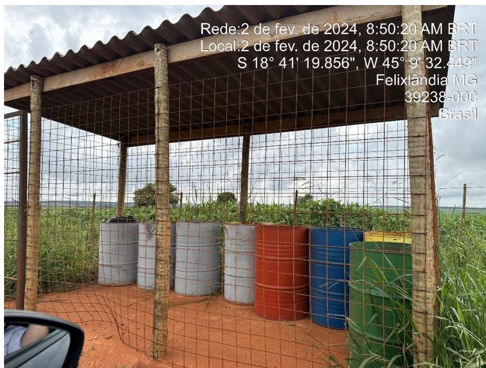
Figura 7. 5-15: Armazenamento temporário de resíduos sólidos com separação por tipologia de resíduos.
