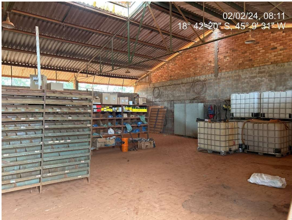
Figura 5.1-6: Galpão de guarda de ferramentas e utensílios.
