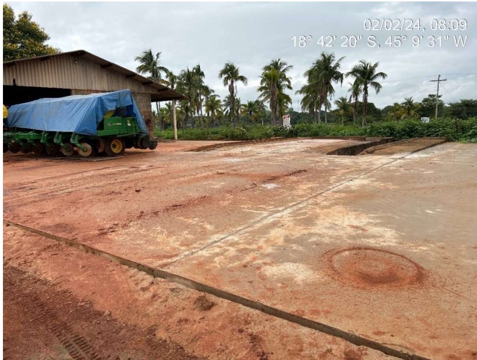
Figura 7.4: Lavador de maquinários com canaletas ligadas à CSAO junto ao ponto de abastecimento.
