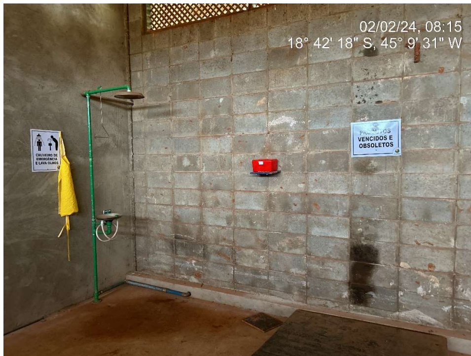
Figura 5.1-11: Recinto para lavagem de olhos e estocagem de produtos inutilizáveis.
